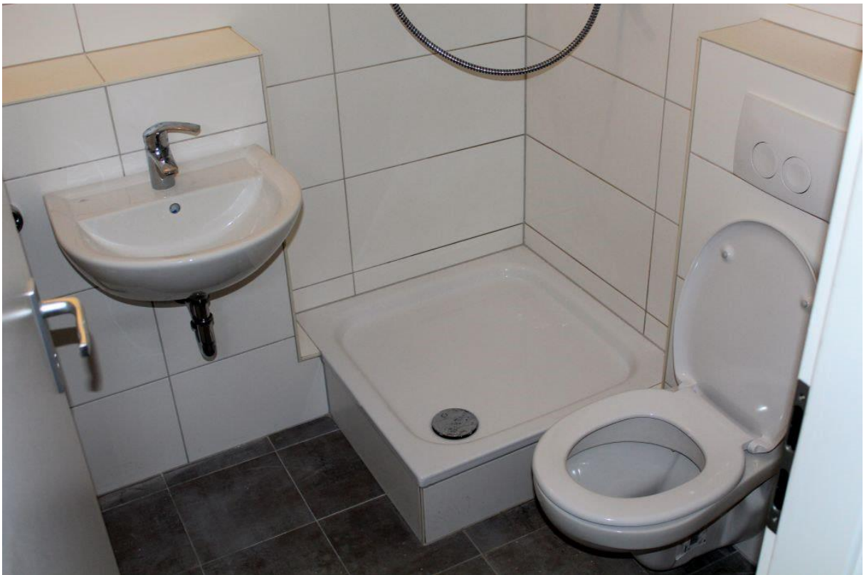
Neu eingebrachte Fliesen und Sanitärobjekte
